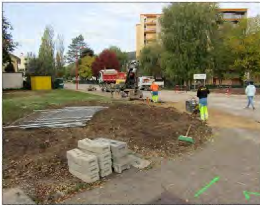
Les travaux à l'intersection de l'avenue du Québec et Jacques Cartier et de la rue des Tilleuls s'étaleront sur environ deux mois. Photo Progrès/Roger GUILLOT
