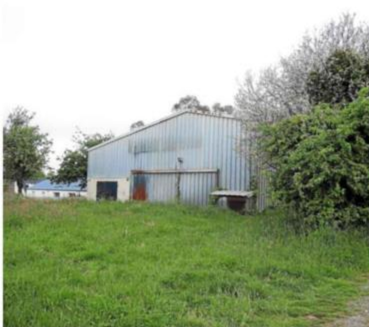
Le site du projet La Forge qui accueillera un espace multiactivités au centre de la commune d'Arzal.
